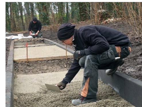
Professionelle Grundlage für Spaziergänge auf nackten Füßen: Ronny Fehrmann glättet mit einer Kelle die erste Schicht für den neuen Barfußpfad. Die sorgfältige Planung sorgt für eine stabile Basis, bevor die unterschiedlichen Bodenmaterialien eingebracht werden. Im Hintergrund arbeitet Maik Schulz an einem weiteren Abschnitt des Pfades.
