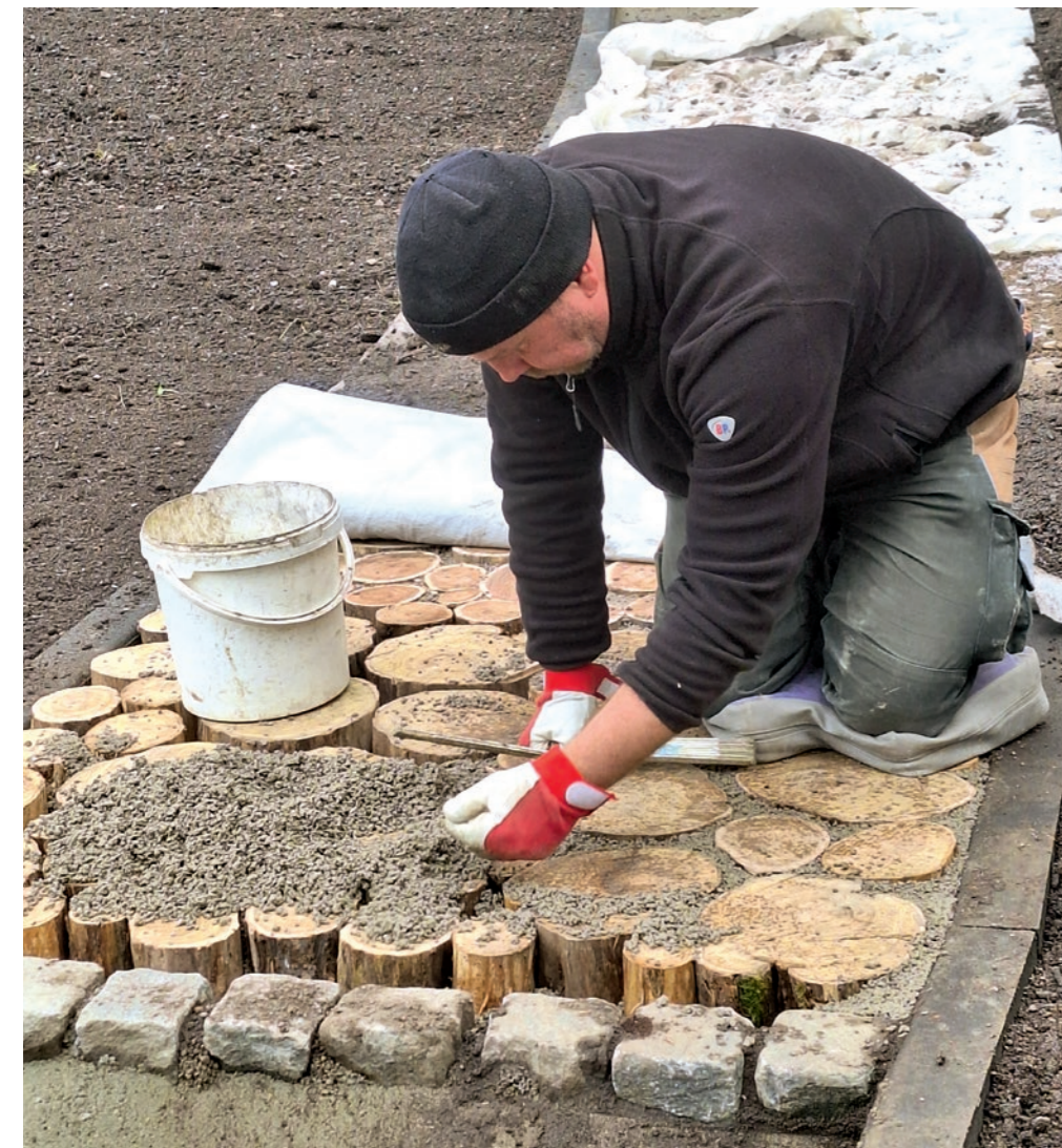
Professionelle Grundlage für Spaziergänge auf nackten Füßen: Ronny Fehrmann glättet mit einer Kelle die erste Schicht für den neuen Barfußpfad. Die sorgfältige Planung sorgt für eine stabile Basis, bevor die unterschiedlichen Bodenmaterialien eingebracht werden. Im Hintergrund arbeitet Maik Schulz an einem weiteren Abschnitt des Pfades.
